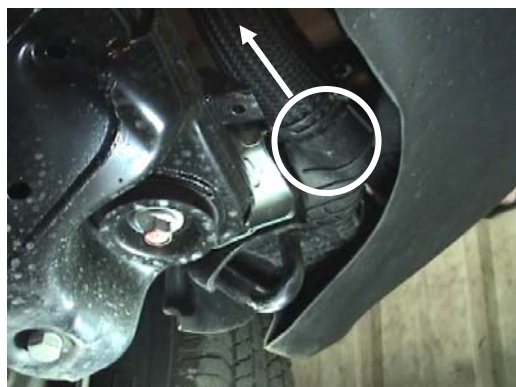
中央空氣冷卻器出口到進氣歧管之進氣軟管洩漏，造成 DPF 阻塞
